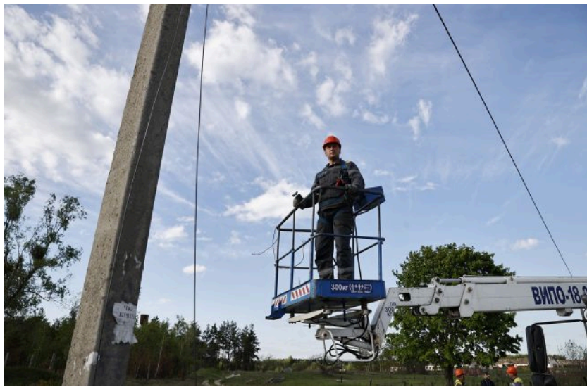
Фото: ремонт електромереж (Getty Images)
